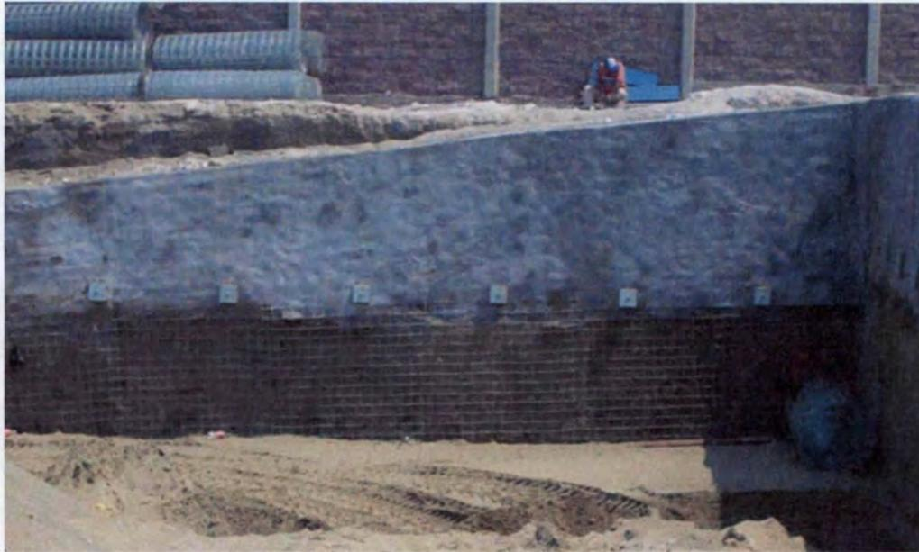
Colocación de malla electro soldada 6-6/6-6 en segundo nivel de anclaje muro sur
