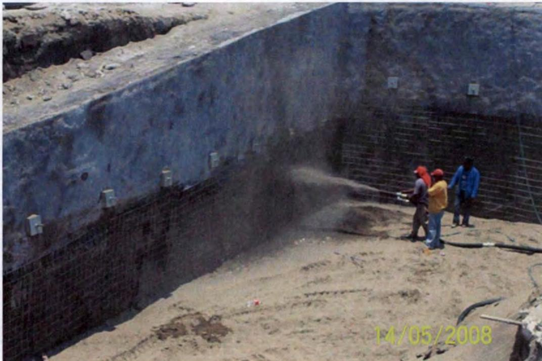
Lanzado de concreto sobre previo afine y colocación de malla
