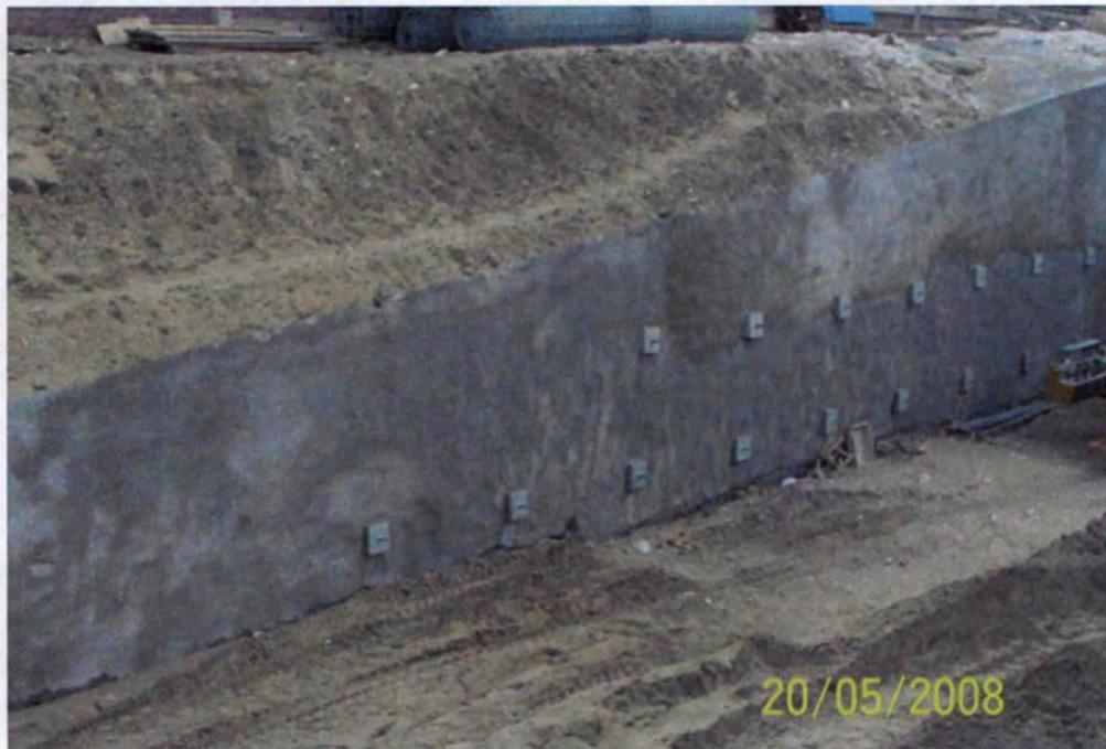
Colocación de placas y primer tensado de anclaje
