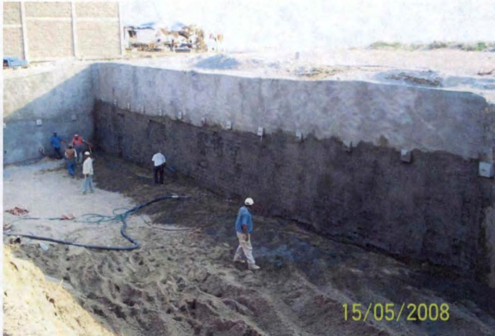
Lanzado de concreto en el muro poniente segundo nivel, obsérvese la longitud del tramo de tratamiento
