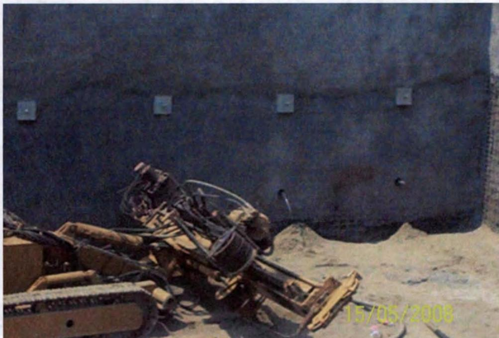
Perforación de anclas en segundo nivel lado sur
