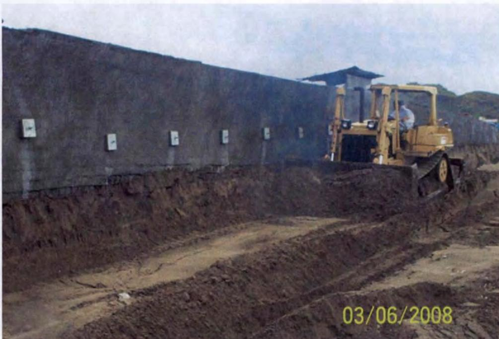
Formación de terraza para segundo nivel de anclaje en el muro lado poniente
